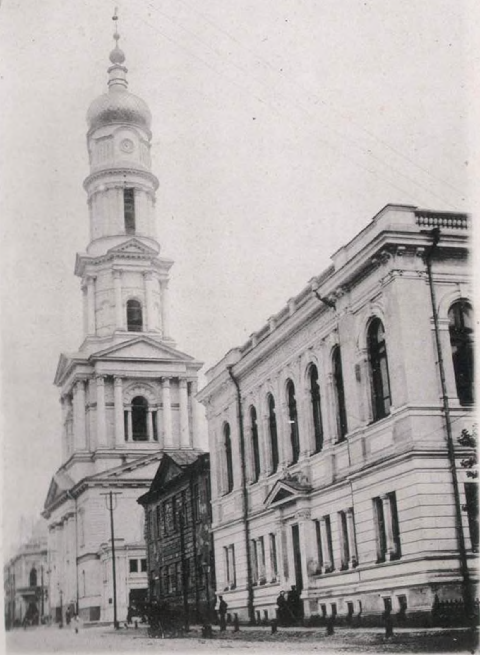
Колокольня Соборной церкви, сооруженная въ память избавле- нія отъ нашествія дванадесяти языковъ въ 1812 г. и зданіе университетской библіотеки въ Харьковѣ.
