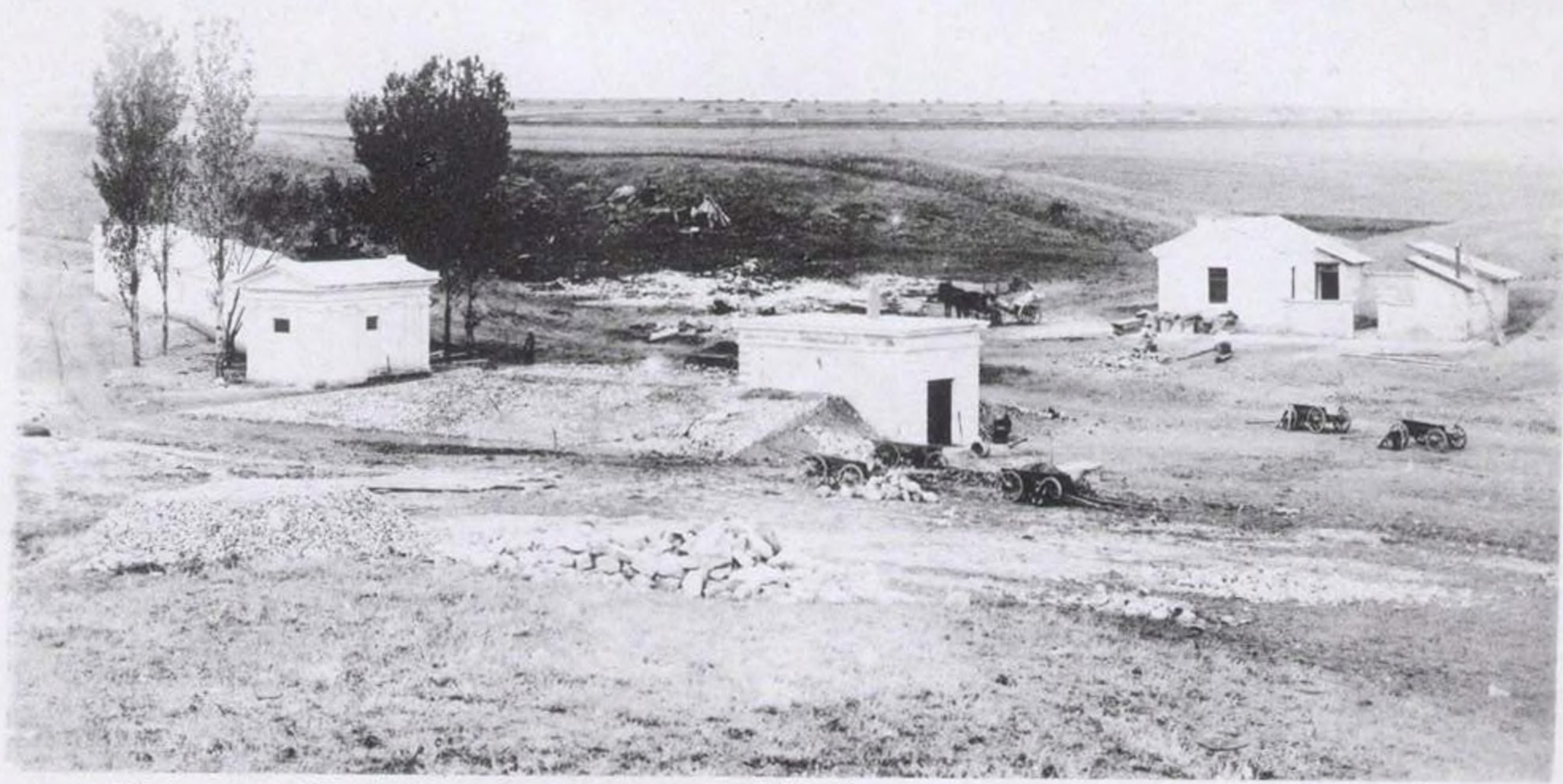
Источникъ Теодосійскаго водопровода К.-Х.-С. ж. д. въ 14 верстахъ отъ Теодосіи. (Влѣво зданіе надъ источникомъ, посрединѣ водосборный бассейнъ, вправо домикъ для сторожа).
