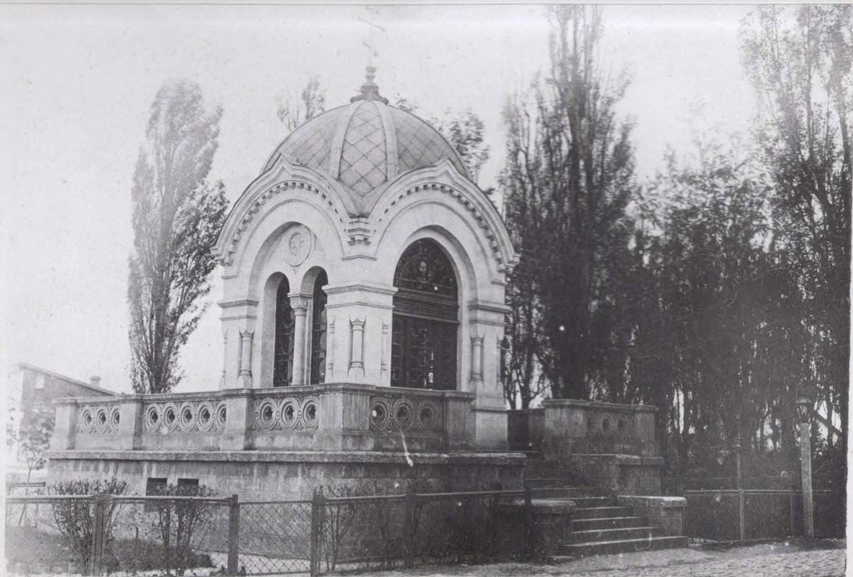
Часовня на ст. Симферополь въ память избавленія отъ опасности Государя Императора въ Отсу.
